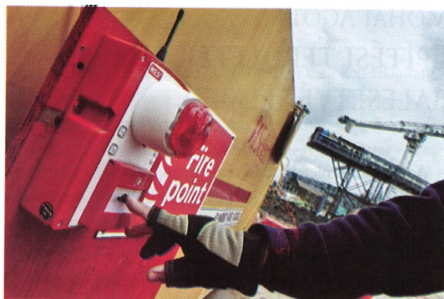
TŰZJELZÉS ÉS RIASZTÁS BIZTOSÍTÁSA A TELJES ÉPÍTÉSI TERÜLETEN
